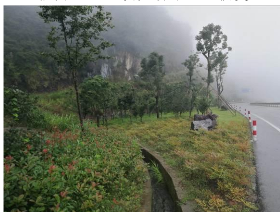
插图 14 K6+350 施工场地迹地恢复
