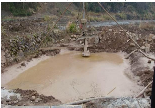
图 3-3 桥梁钻基础施工沉淀池(徐村大桥)
