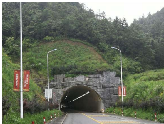
图 8 岭后隧道出口边坡绿化
