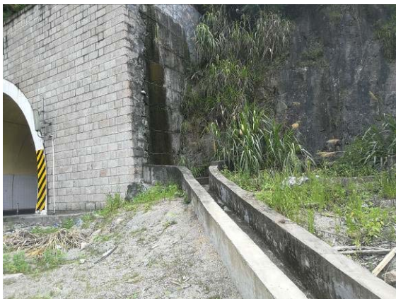
图 7 十八尖隧道出口截水沟
