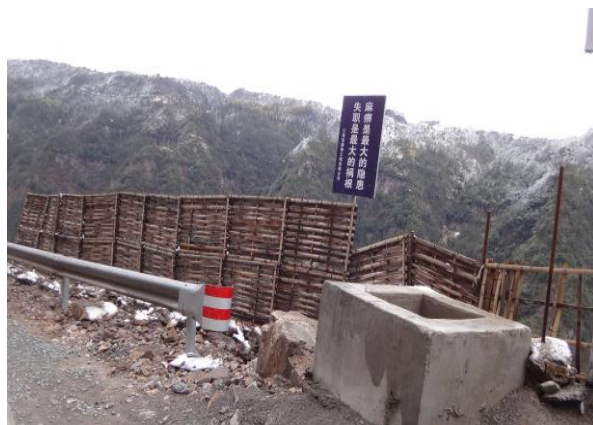
图 3-2 2 标路基施工拦渣栅栏临时拦挡
