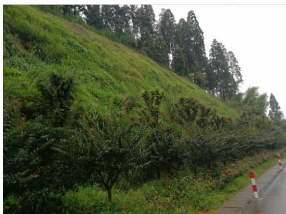
插图 7 二源连接线起点段边坡绿化及排水
