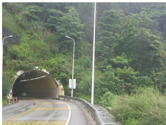
插图 10 徐村隧道进口洞脸边坡绿化
