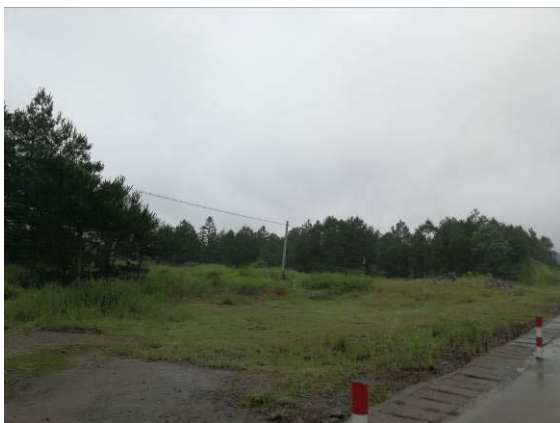
图 11 K20+850 施工场地迹地恢复
