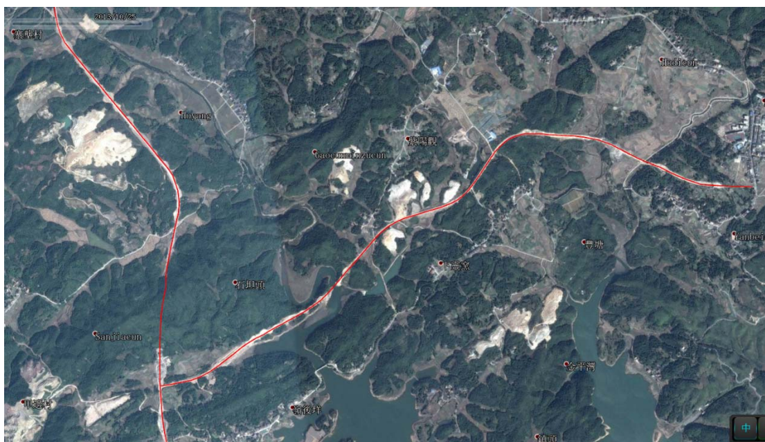
二源连接线施工中影像资料（2013 年 10 月）
