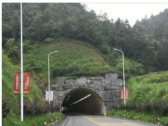
插图 11 岭后隧道出口边坡绿化
