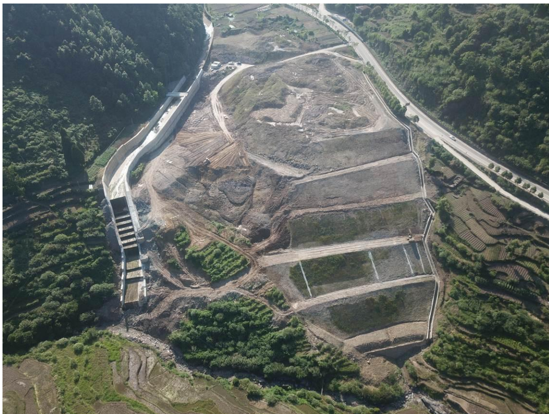
图 1 林坑弃渣场现状
