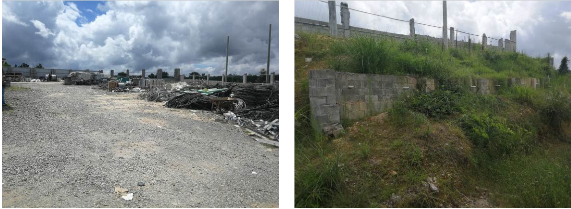
图3 马垄底弃渣场现状
