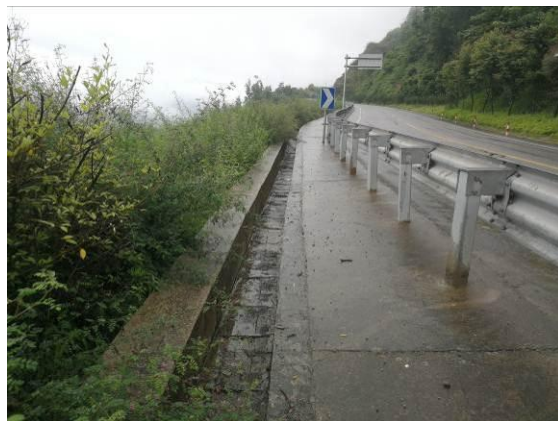
插图 4 K3+000 路基排水沟
