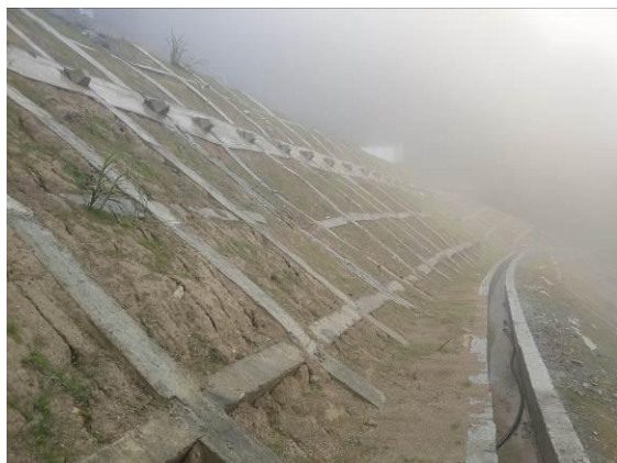
图 7-1 K10+000 路基边坡绿化效果欠佳
