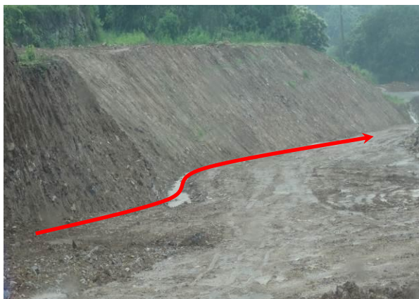
图 3-1 1 标路基开挖临时排水沟
