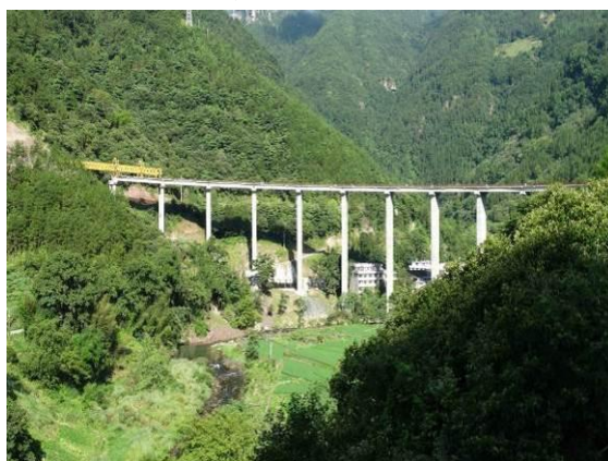
插图 12 泗溪大桥下迹地恢复
