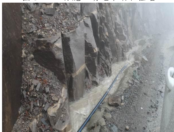
图 3-6 3 标施工便道临时排水沟
