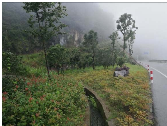
图 10 K6+350 施工场地迹地恢复
