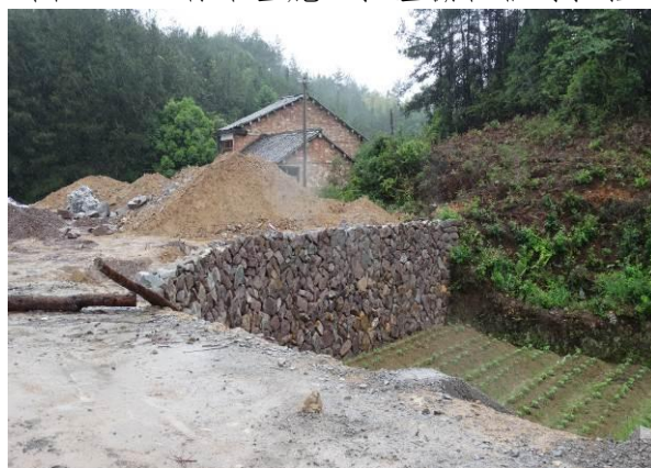
图 3-4 2 标施工场地干砌石挡墙
