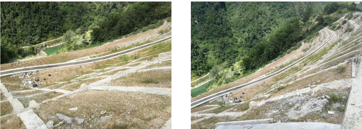
图 6-1 沿线溜渣边坡治理和二级水电站水库大坝下游河道右岸堆渣清理
