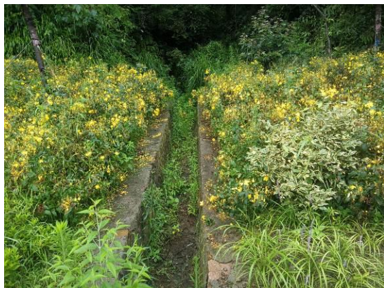
插图 3 K1+500 附近路基截水沟及边坡绿化
