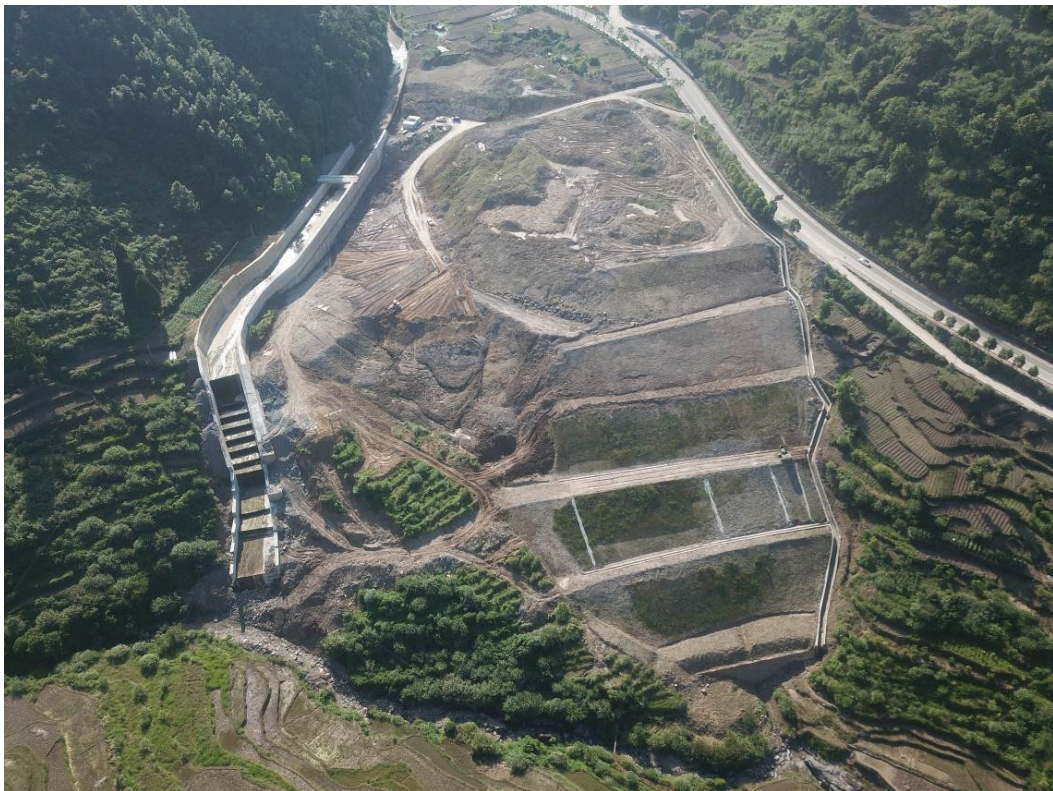
图 1 林坑弃渣场现状
