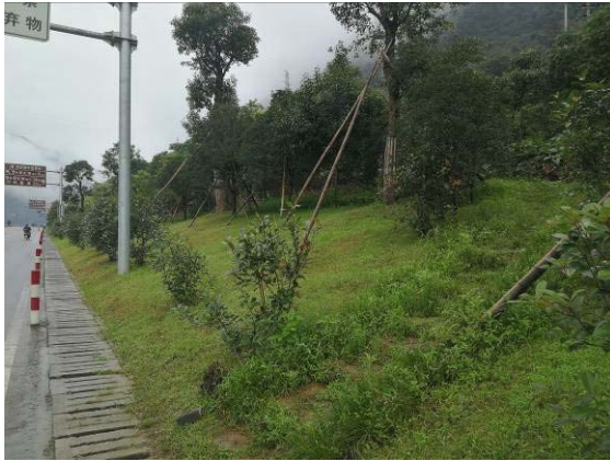
图 1 路基起点段排水边沟及绿化
