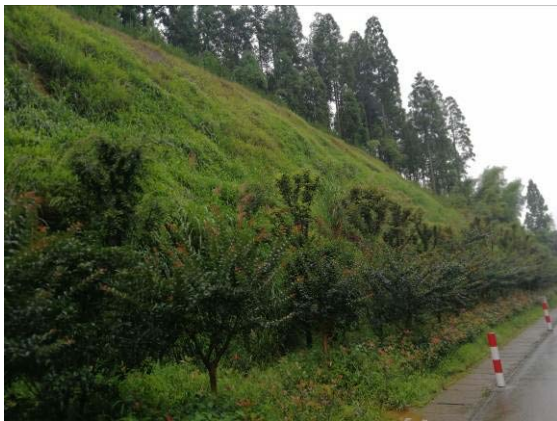
图 5 二源连接线起点段边坡绿化及排水
