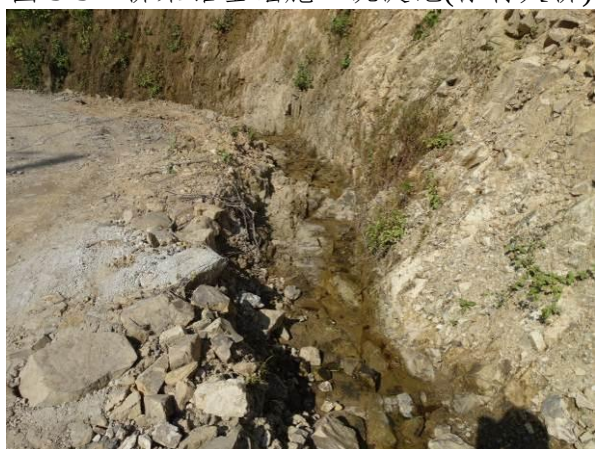
图 3-5 1 标施工便道临时排水沟
