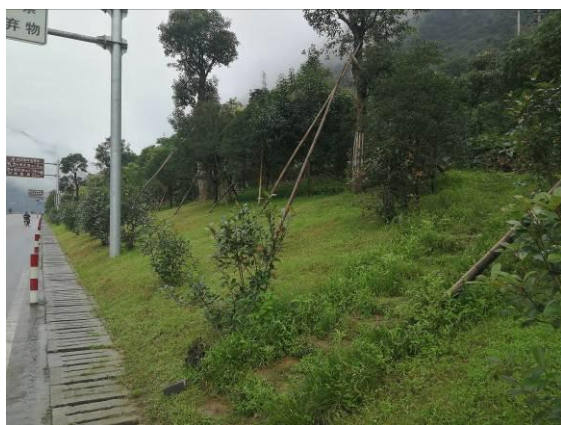
插图 1 路基起点段排水边沟及绿化
