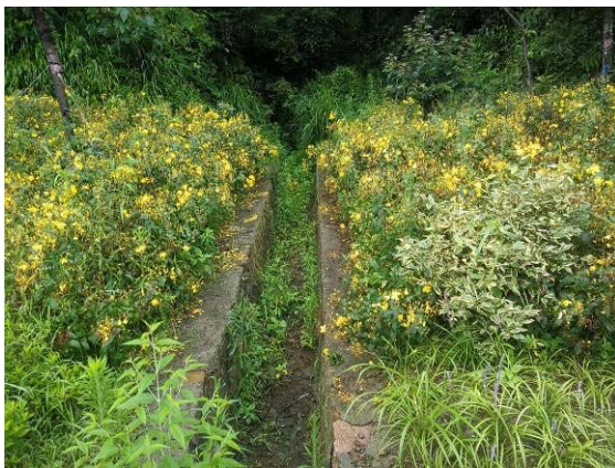
图 3 K1+500 附近路基截水沟及边坡绿化
