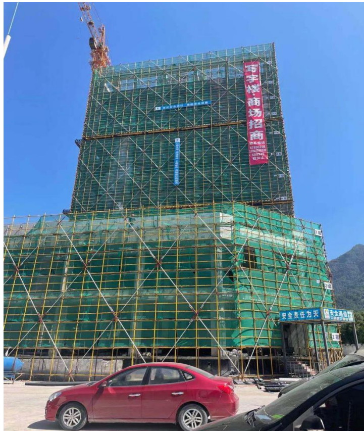
图 1 项目区主体工程现状
