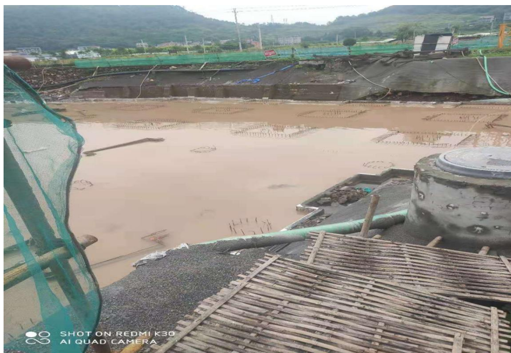
图 1 项目区主体工程现状
