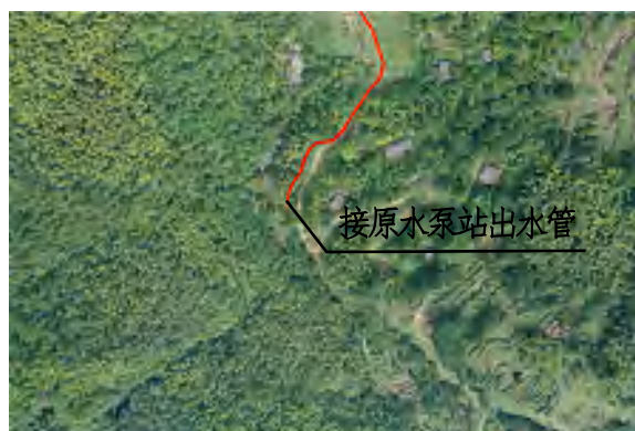
图 2-2 原水工程起点
