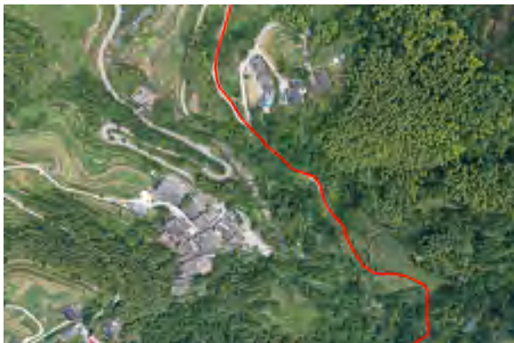
图 2-3 原水管线现状
