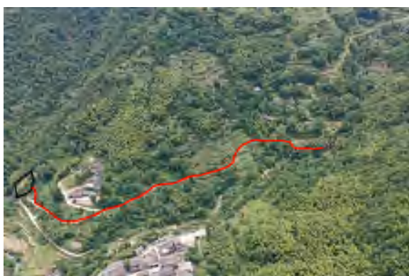
图 2-1 厂区和原水管线
