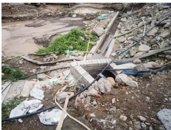
现有排水沟沉沙井
