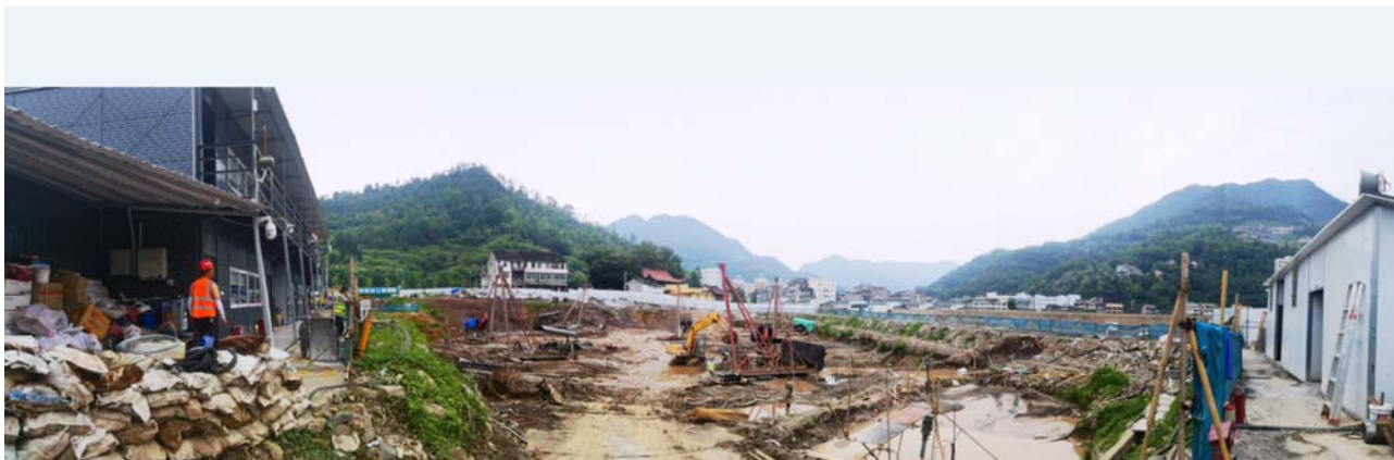
项目区场内现状
