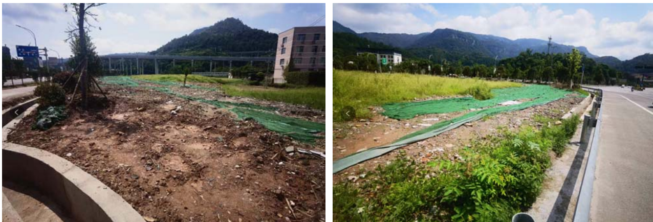
文成县樟台学校扩建工程回填区域现状
