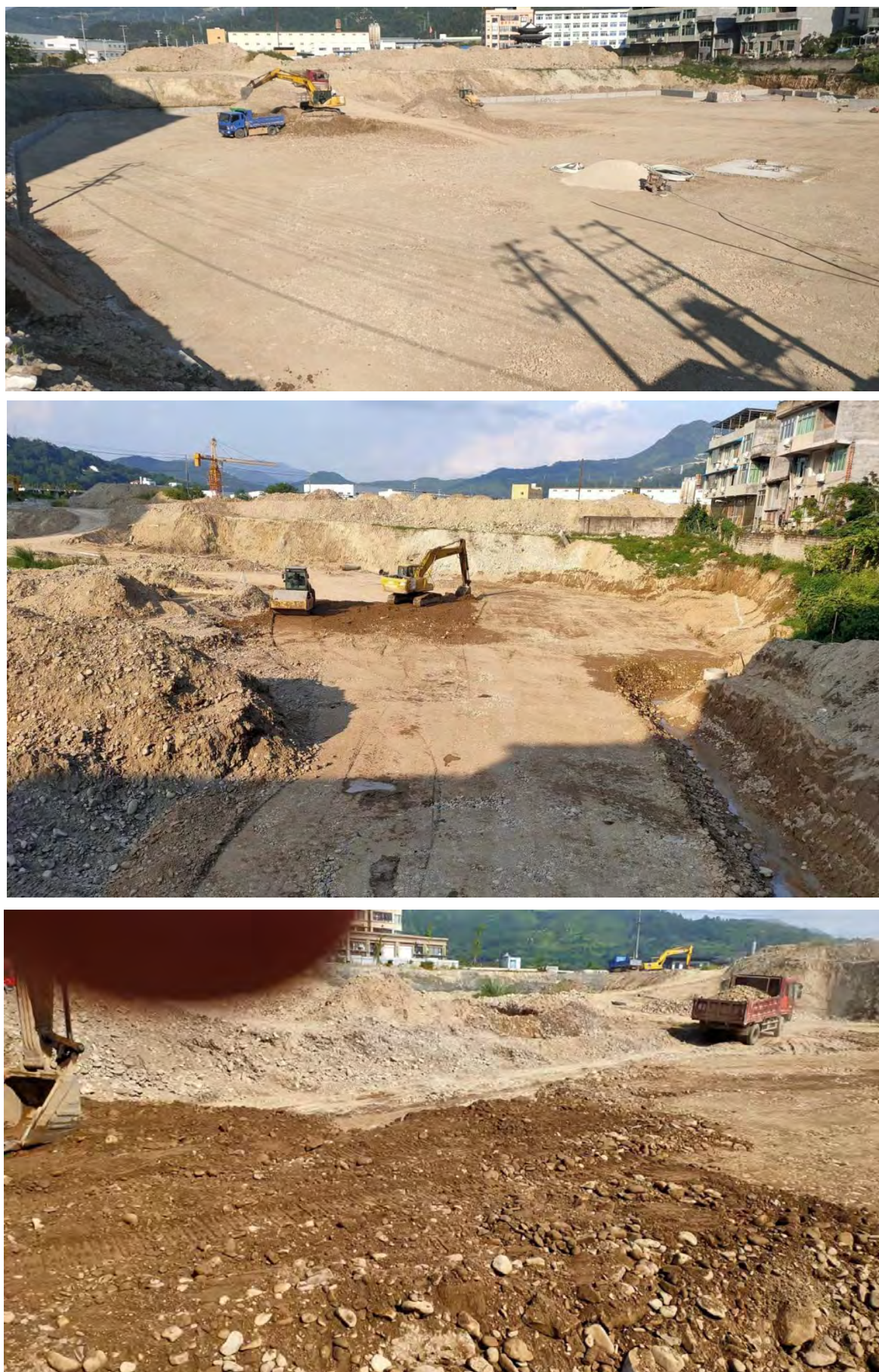
图 2 施工过程中影像照片
