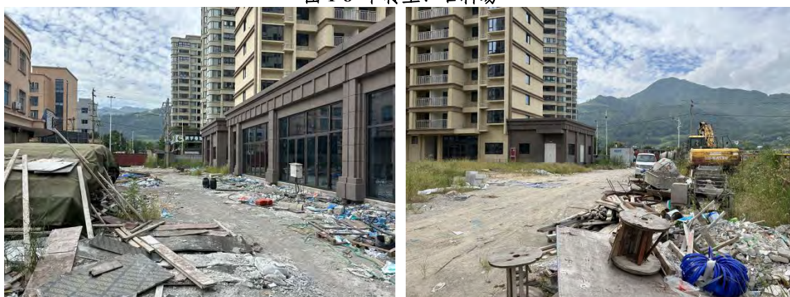
图 1-9 施工临时便道
