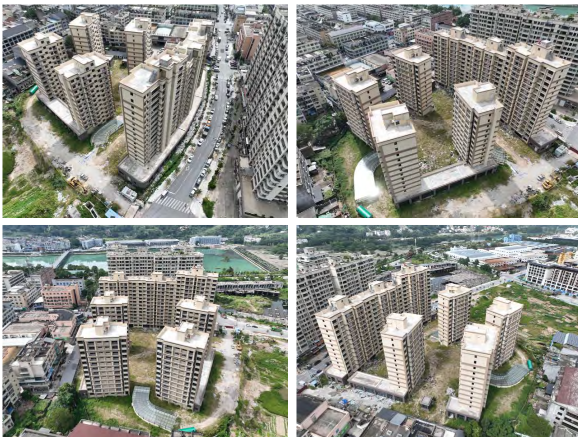
图3 项目区现状照片
