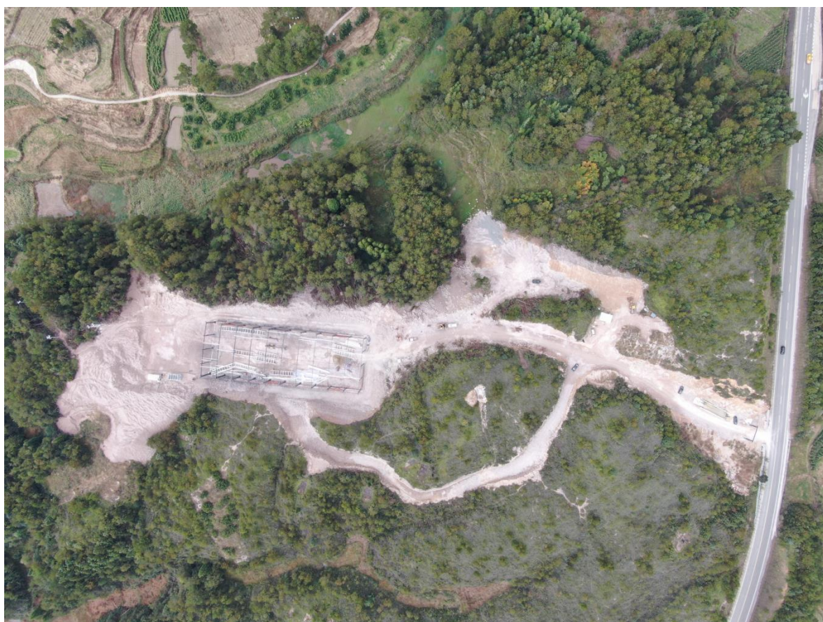
项目区航拍（拍摄于 2023.10）
