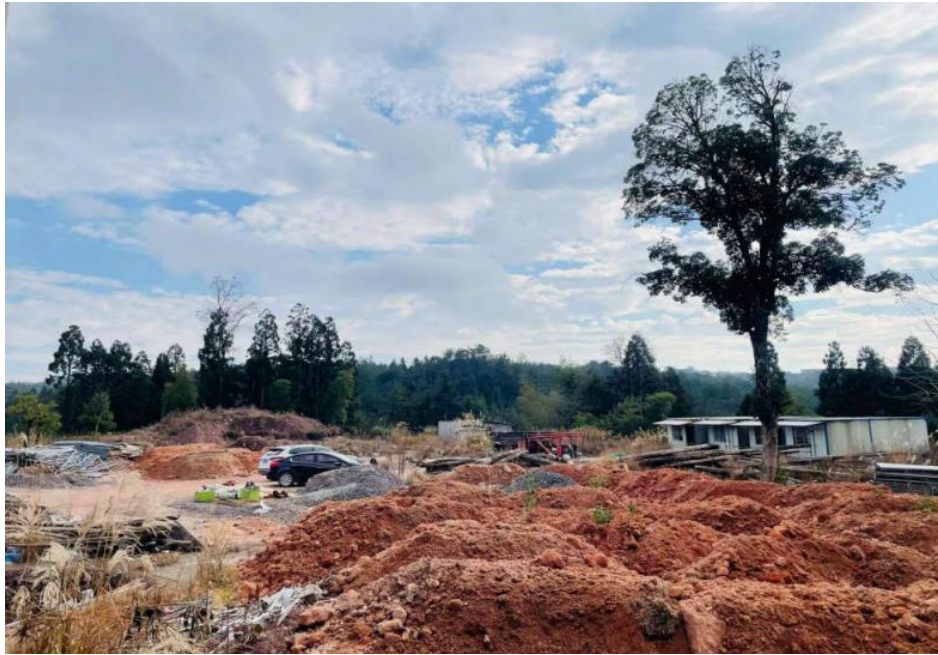
图 1.1-3 项目区现状（场地北侧，镜头朝南）
