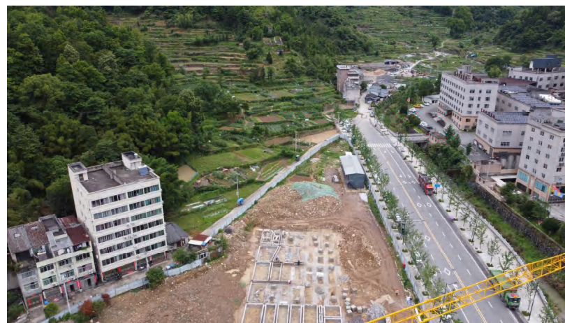
项目北侧及东侧
