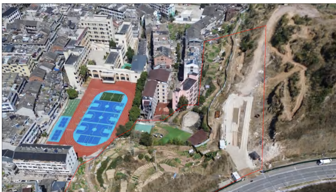
图 1 项目建设区现状（摄于 2025 年 3 月）
