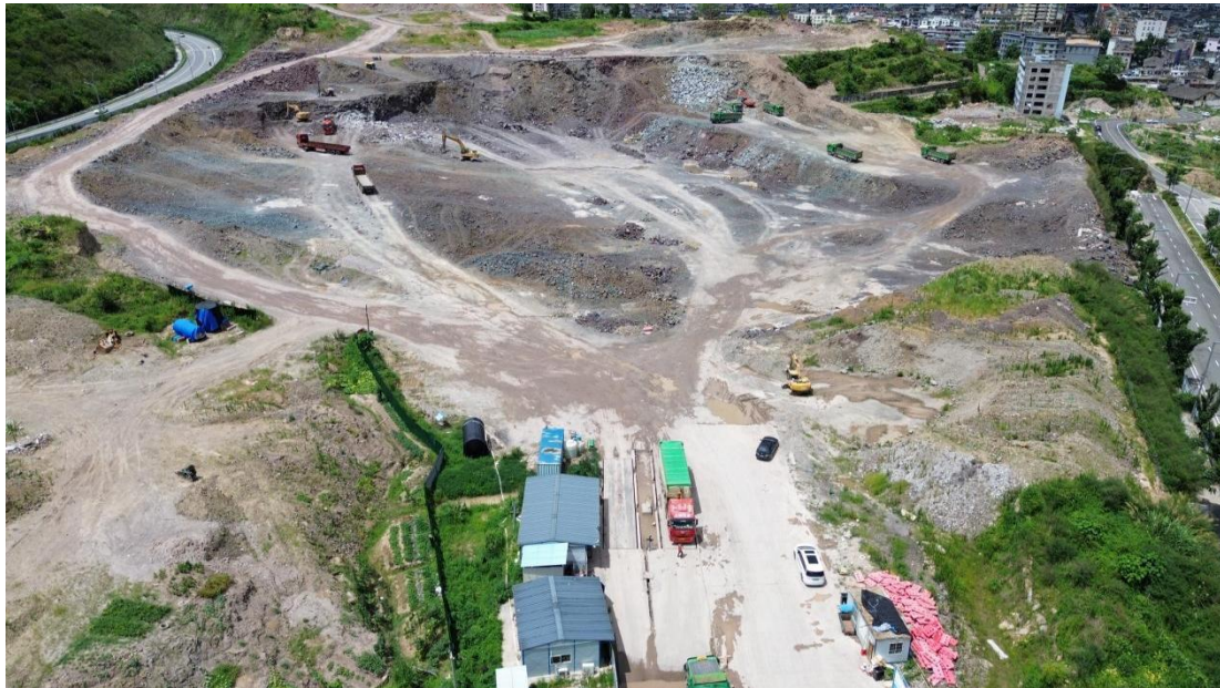
图 4 东侧在建项目浙江文成经济开发区樟山产业基地配套设施项目一期-樟山产业基地土地平整工程
