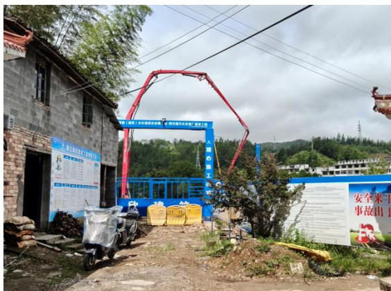
工程施工现状（2025.09）
