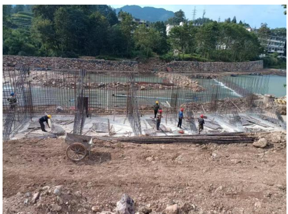
工程施工现状（2025.09）
