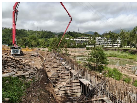
工程施工现状（2025.09）
