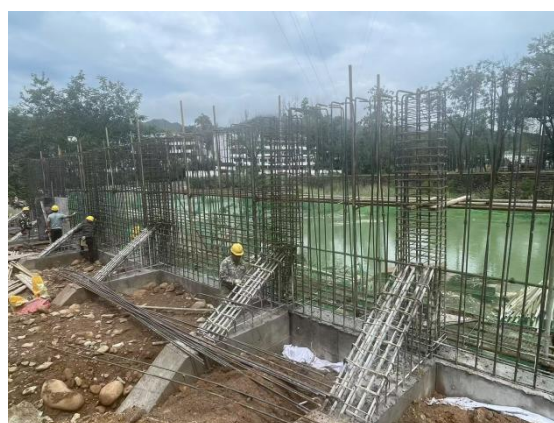
工程施工现状（2025.09）
