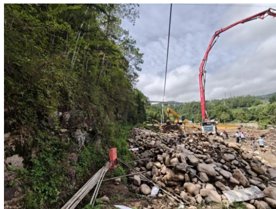
工程施工现状（2025.09）
