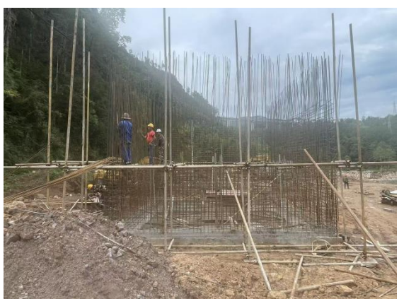
工程施工现状（2025.09）
