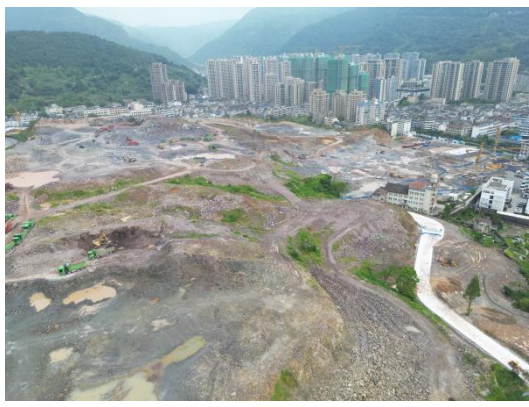
图 1-7 北侧浙江文成经济开发区樟山产业基地配套设施项目一期-樟山产业基地土地平整工程
