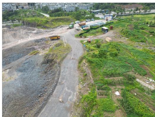
图 1-5 南侧浙江文成经济开发区樟山产业基地配套设施项目一期-樟山产业基地土地平整工程
