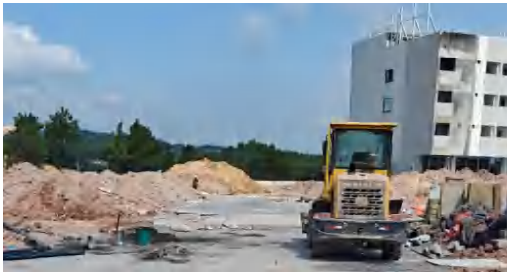
图 10 现场施工现状（2026.9）
