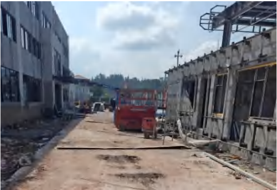
一期施工现场照片（2026.9）
