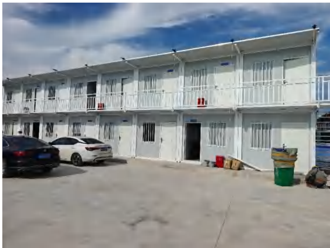
一期生活生产区现场照片（2026.9，位于二期扰动范围内）
