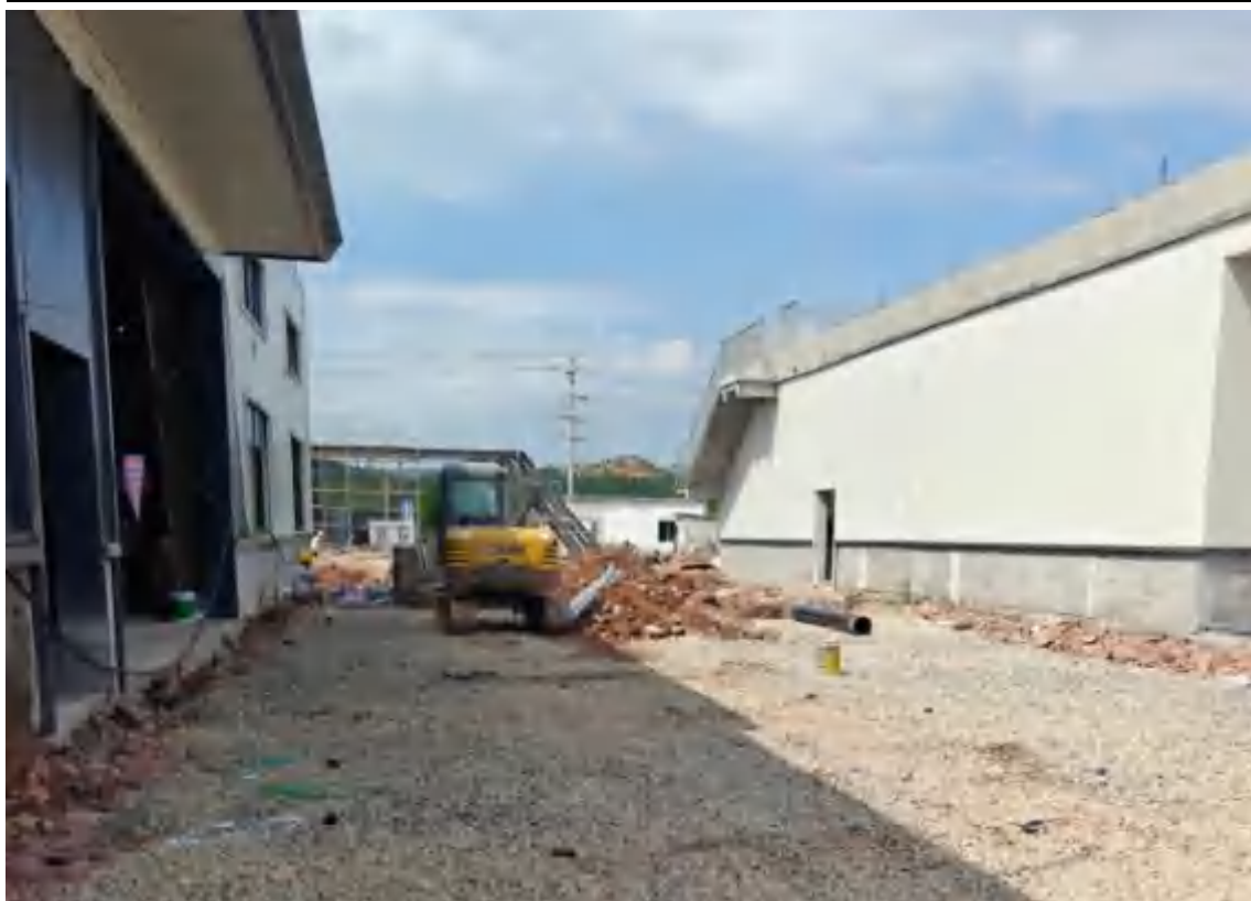
一期施工现场照片（2026.9）
