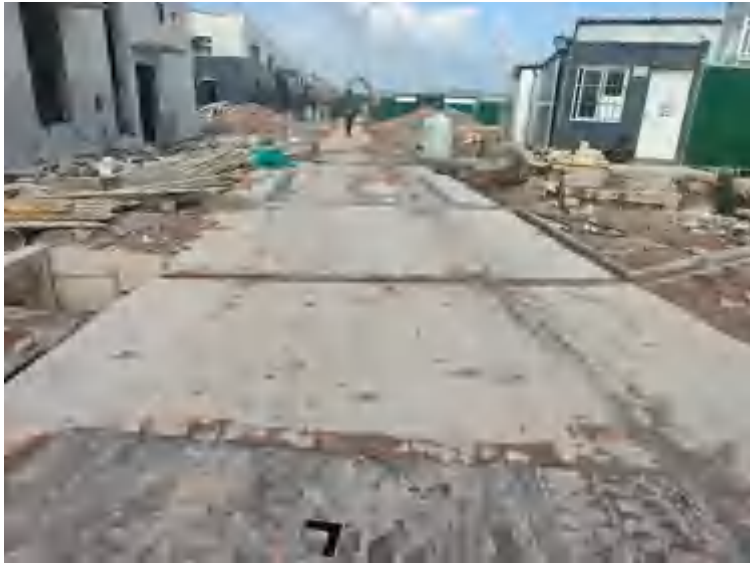
图 9 施工便道照片（2026.9）
